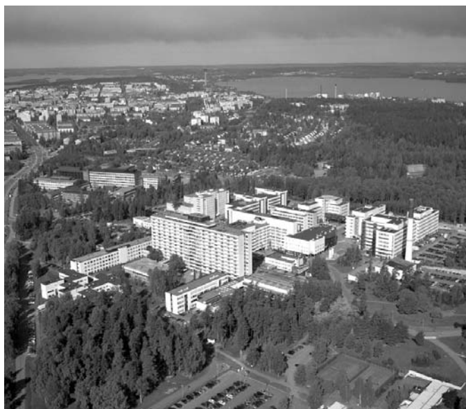
Tamperská univerzitní nemocnice
