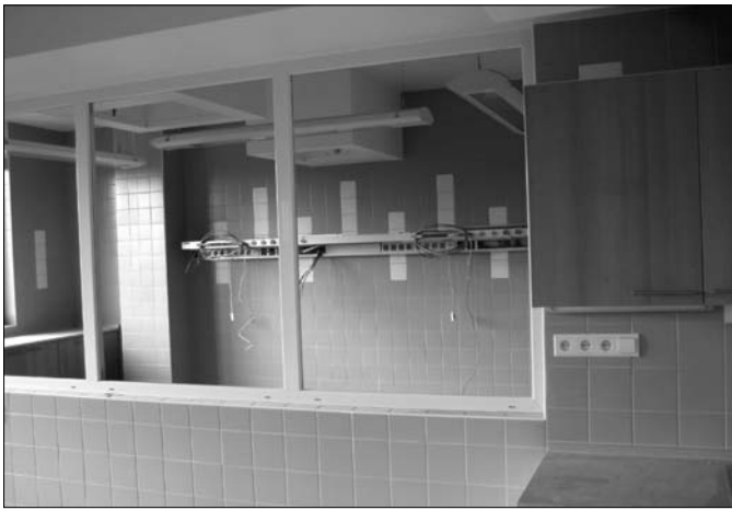
Montáž rampy na JIP Plicní kliniky pavilonu č. 14.
