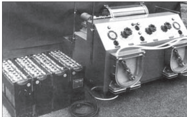
Přístroj pro mimotělní oběh zhotovený v ZVU Hradec Králové
