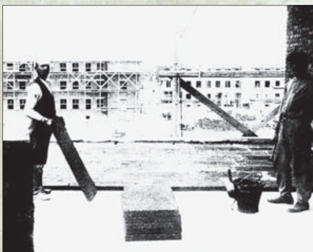
Stavba nemocnice v roce 1927
