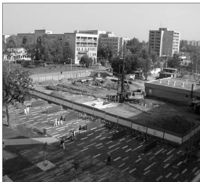
Staveniště budoucího Výukového centra.
