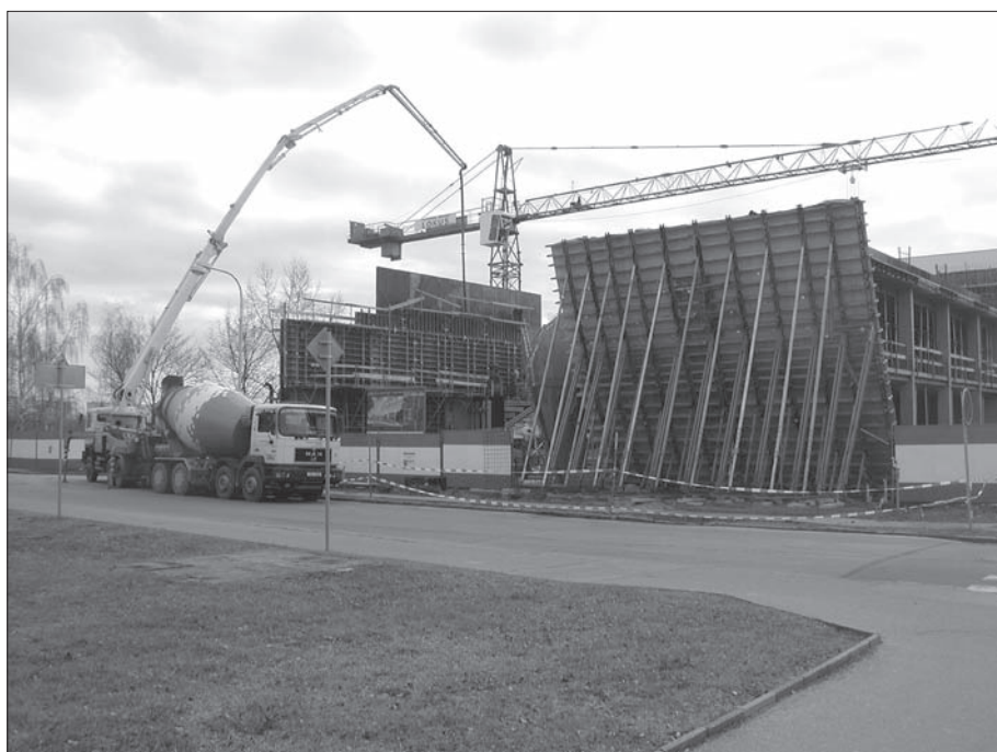
Výstavba v areálu Fakultní nemocnice Hradec Králové pokračuje. Na fotografii Ing. Jiřího Bobra je zachycena betonáž obvodových stěn Výukového centra LF UK.
