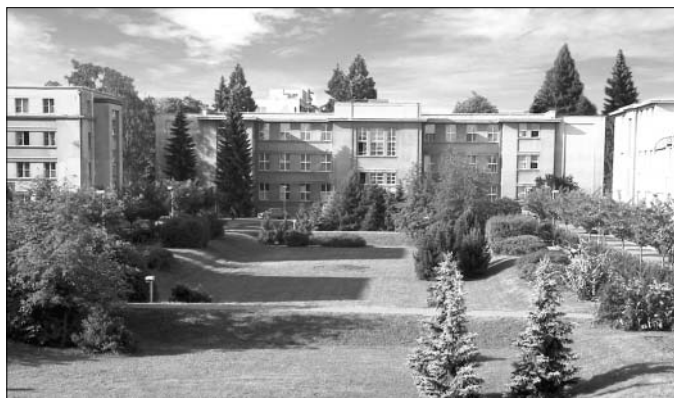
Vstupní areál nemocnice.
