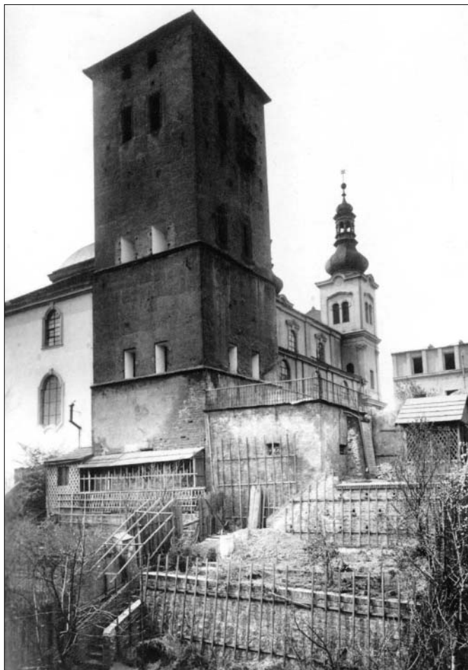
Kropáčka, vodní věž, v jejímž přízemí byl v roce 1857 „záchranný ústav“ pro výtržníky a nevěstky.
