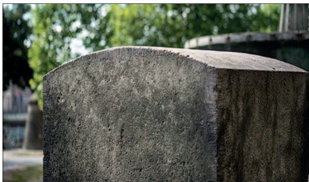
Detail obrubového kamene, kamenické práce Václav Škoda, 1912
