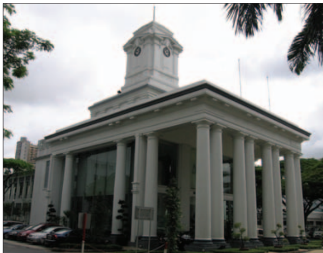
Bowyer Block, postavený v koloniálním stylu, býval hlavní budovou nemocnice. Dnes zde sídlí muzeum SGH.
