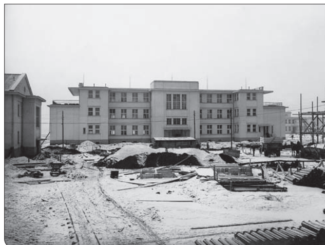
Stavba pavilonu interny Okresní nemocnice, 1928, Sbíрка MVČ
