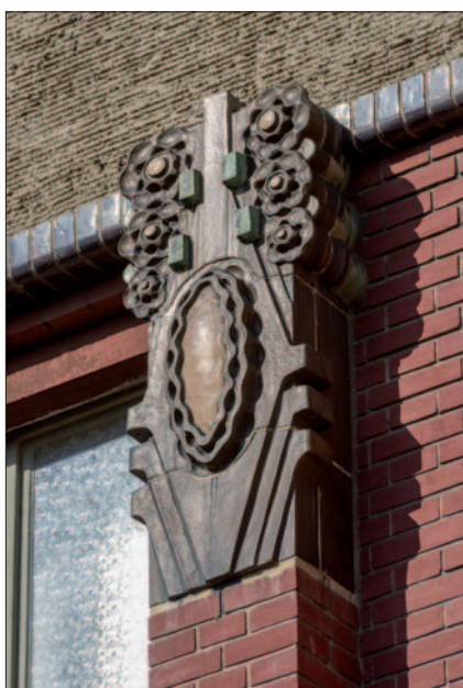
Ozdobné ukončení fiály na západní fasádě jižního křídla, 1911
