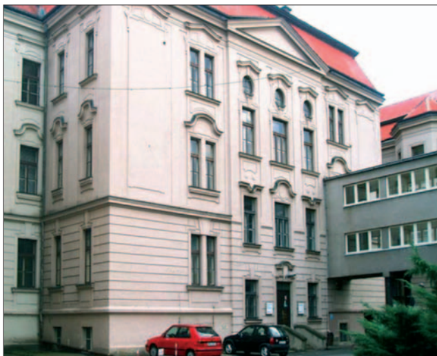
Bývalá budova kliniky do roku 2004 – Ústav hluchoněmých
