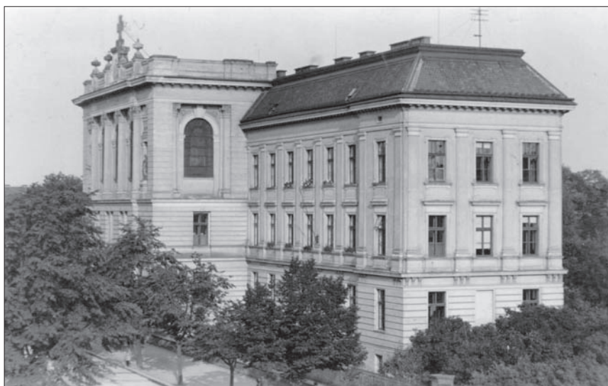
Budova penzionátu a školy na Pospíšilově třídě, 20. léta 20. století
