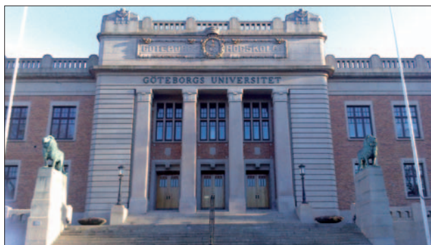
Budova děkanátu University of Gothenburg
