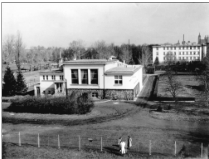
Prosektura po dostavbě Všeobecné veřejné okresní nemocnice, 1929. Foto A. Fingerland
