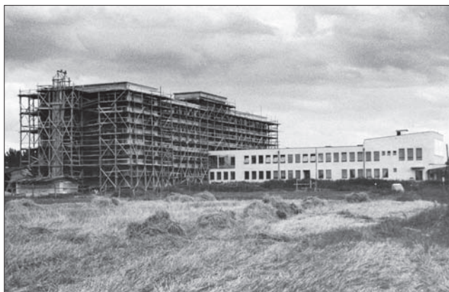
Stavba lůžkové části dětské kliniky
