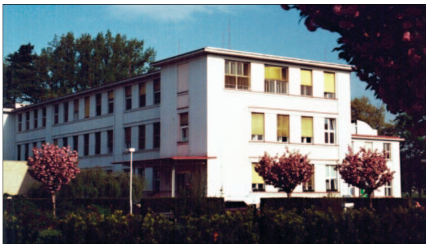
Celkový pohled na budovu ortopedické kliniky.
