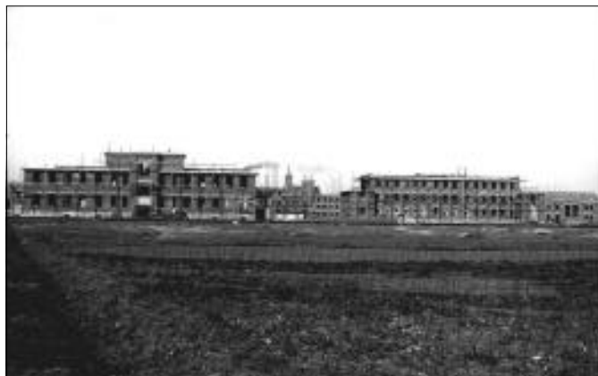
Celkový pohled na stavbu.
