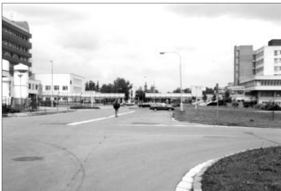
Snímek do archivu. Již v září t. r. by měla být zahájena výstavba pavilonu interních oborů, který se „rozkročí“ nad dnešní hlavní tepnou FN. Foto PhDr. Vladimír Panoušek
