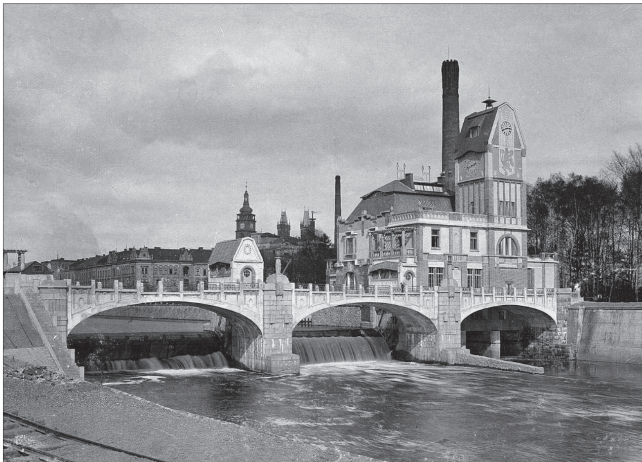
Labská elektrárna, jez Hučák, 20. léta 20. století
