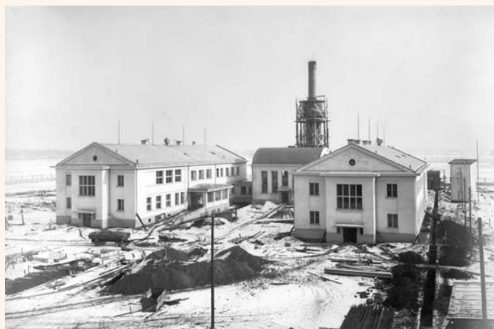
Stavba areálu nemocnice
