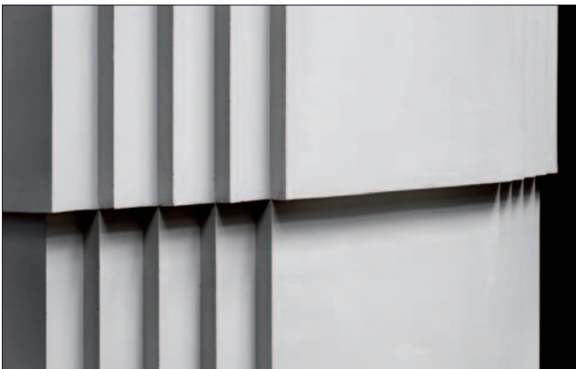
Detail sloupu s ústupkovitě zkosenými rohy
