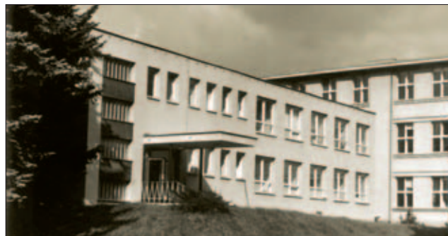
Obr. 3: Jednopatrová přístavba I. interní kliniky v r. 1967
