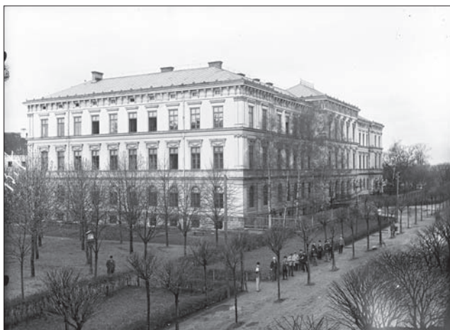
Budova bývalé reálky v Komenského ulici, poč. 20. století, Sběrka MVČ
