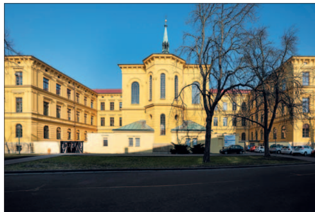
Současná budova školy, zadní trakt s původní kaplí, foto M. Beneš
