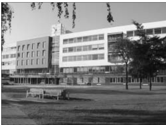
Pohled na pavilon interních oborů s dominantou „skleněné věže“. Foto Ing. Jiří Bobr
