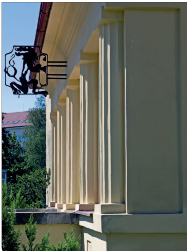
Studentský domov, detail kanelovaných pilastrů ve vstupním traktu, 2012, foto Jiří Zikmund
