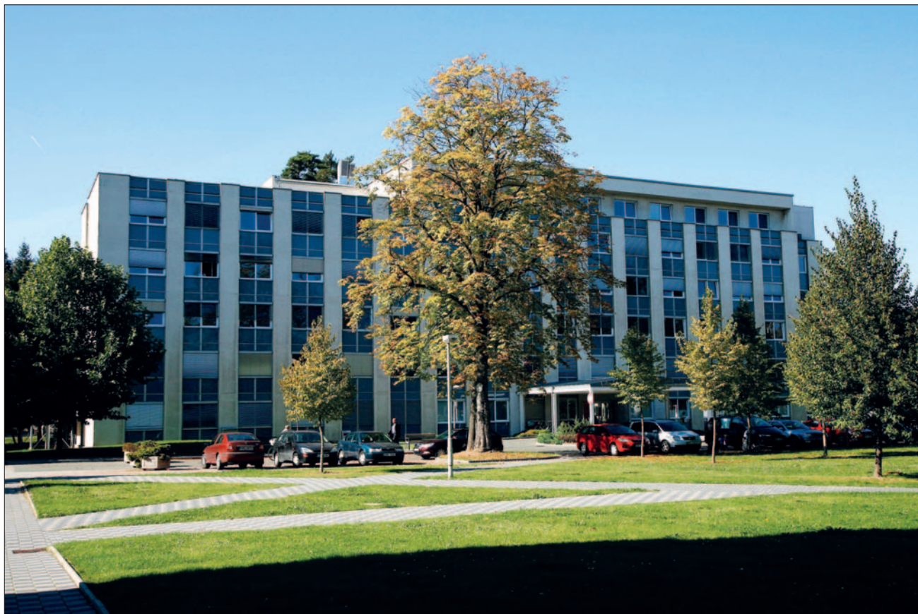
Plicní pavilon budova č. 14 (2011)
