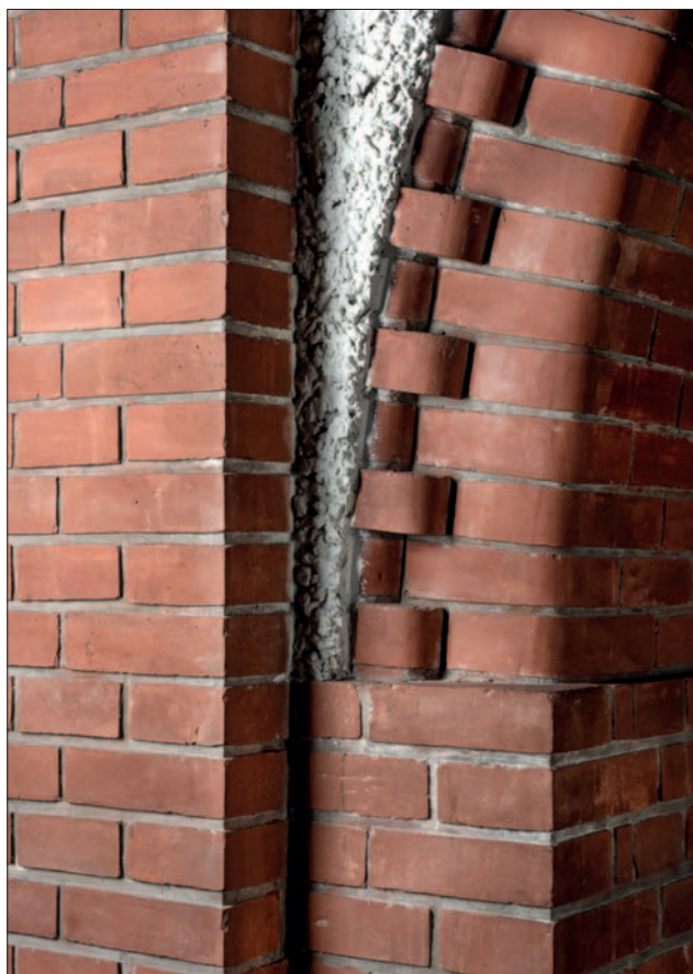
Kontrast režných cihel a česané omítky na sloupu v lapidáriu
