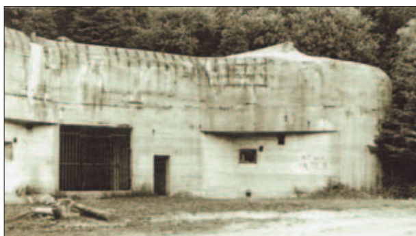
Vchodový objekt těžkého opevnění BOUDA u Králík
