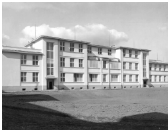
Pavilon oční - ušní před dostavbou.
