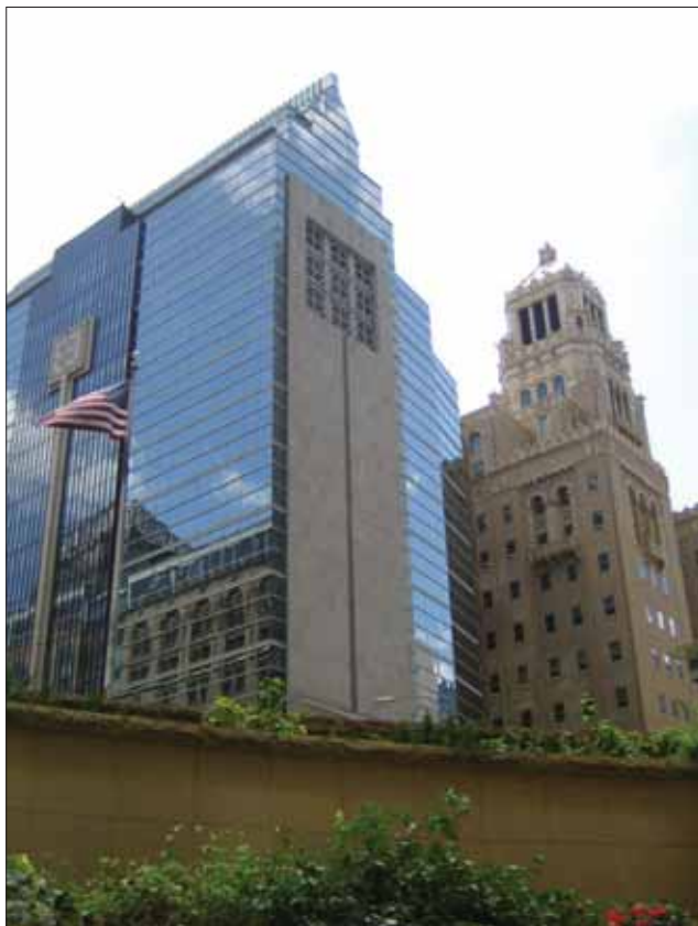
Nejstarší budova Mayo Clinic – Plummer Building a mladší „dvojče“ Siebens Building.
