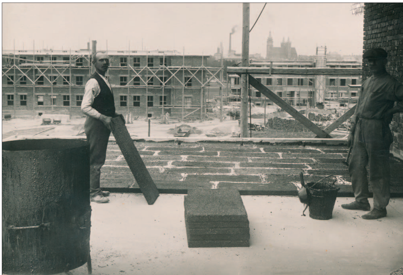
Stavba okresní nemocnice – dělníci při stavbě dvojpavilonu pro oční oddělení a oddělení ORL, 1927
